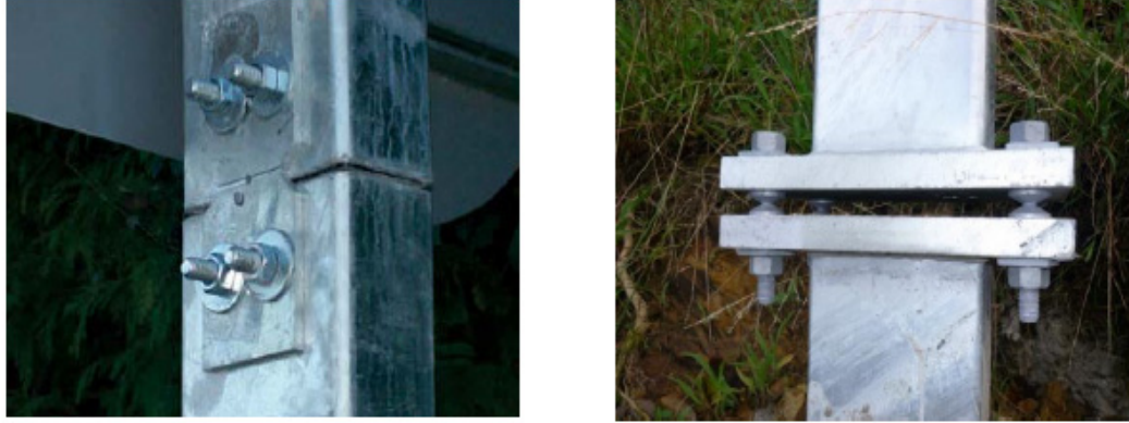
Şekil 37: Kopmalı/uçları bağlanmış direk (sol) ve kayan taban (sağ) [57]
