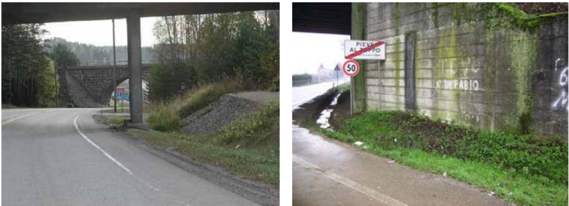
Şekil 52: Tehlikeli köprü ayağı (sol) ve üstgeçit (sağ) örnekleri (Kaynak: [A.2])
