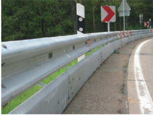
Şekil 80: Sürekli yüzeye olanak sağlayan motosikletliler için bariyer sistemi örnekleri (Kaynak:[A.38])
