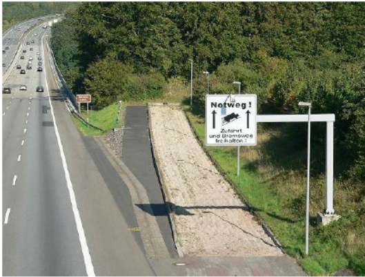
Şekil 68: Acil kaçış rampası [A.50] ve durdurucu tabakaların örnekleri
