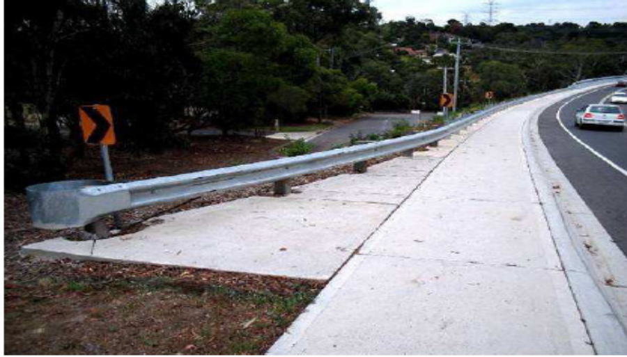
Şekil 4: Yatay olarak kaydırılmış sonlandırıcı [9]
