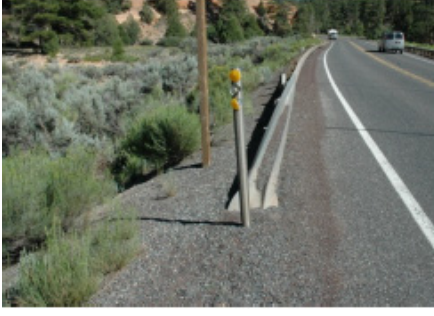
Şekil 10: Devrik sonlandırıcı (sol) ve yatay olarak kaydırılmış-alçaltılmış sonlandırıcı (sağ)
