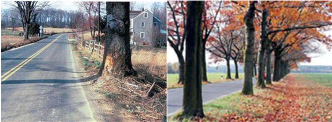
Şekil 49: Yol kenarında tehlikeli konumda yer alan ağaçların örnekleri (Kaynak: [A.24], [A.53])
