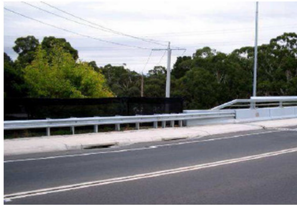
Şekil 75: Yarı-rijit ve rijit bariyer arasındaki geçiş [A.40]
