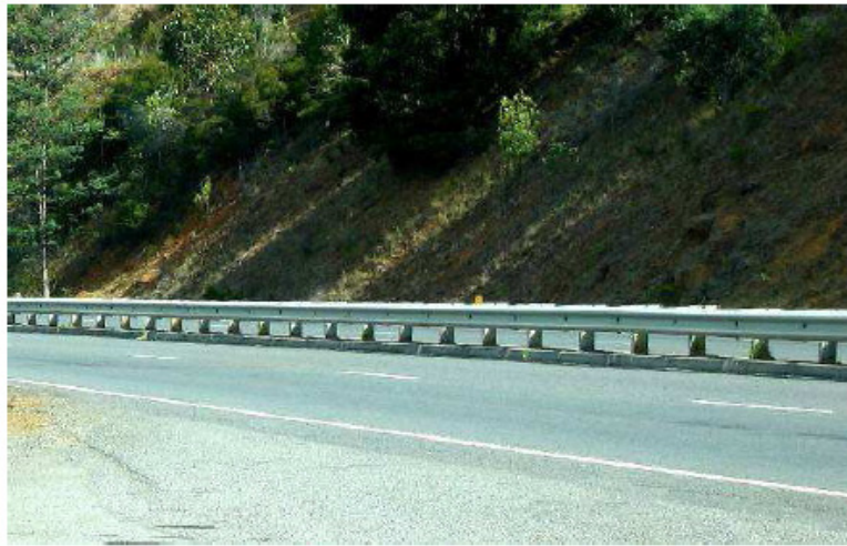
Şekil 78: Tipik W-kırıslı orta refüj yerleştirmesi [A.40]
