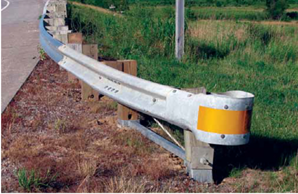
Şekil 7: TL -2 seviyesi için Tescilsiz Tadil Edilmiş Eksantrik Yükleyici Sonlandırıcı (MELT) [10]
