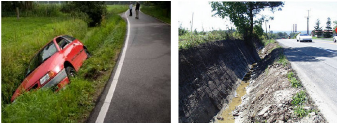
Şekil 57: Tehlikeli yol kenarı hendeği örnekleri (Kaynak: [A.26])
