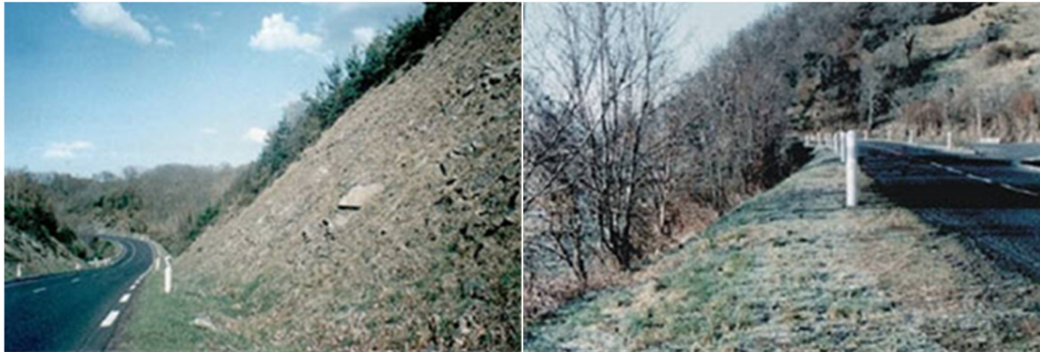
Şekil 56: Tehlikeli yarma (sol) ve dolgu şevi (sağ) örnekleri (Kaynak:[A.2])
