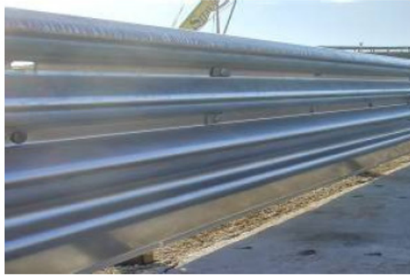
Şekil 80: Sürekli yüzeye olanak sağlayan motosikletliler için bariyer sistemi örnekleri (Kaynak:[A.38])
