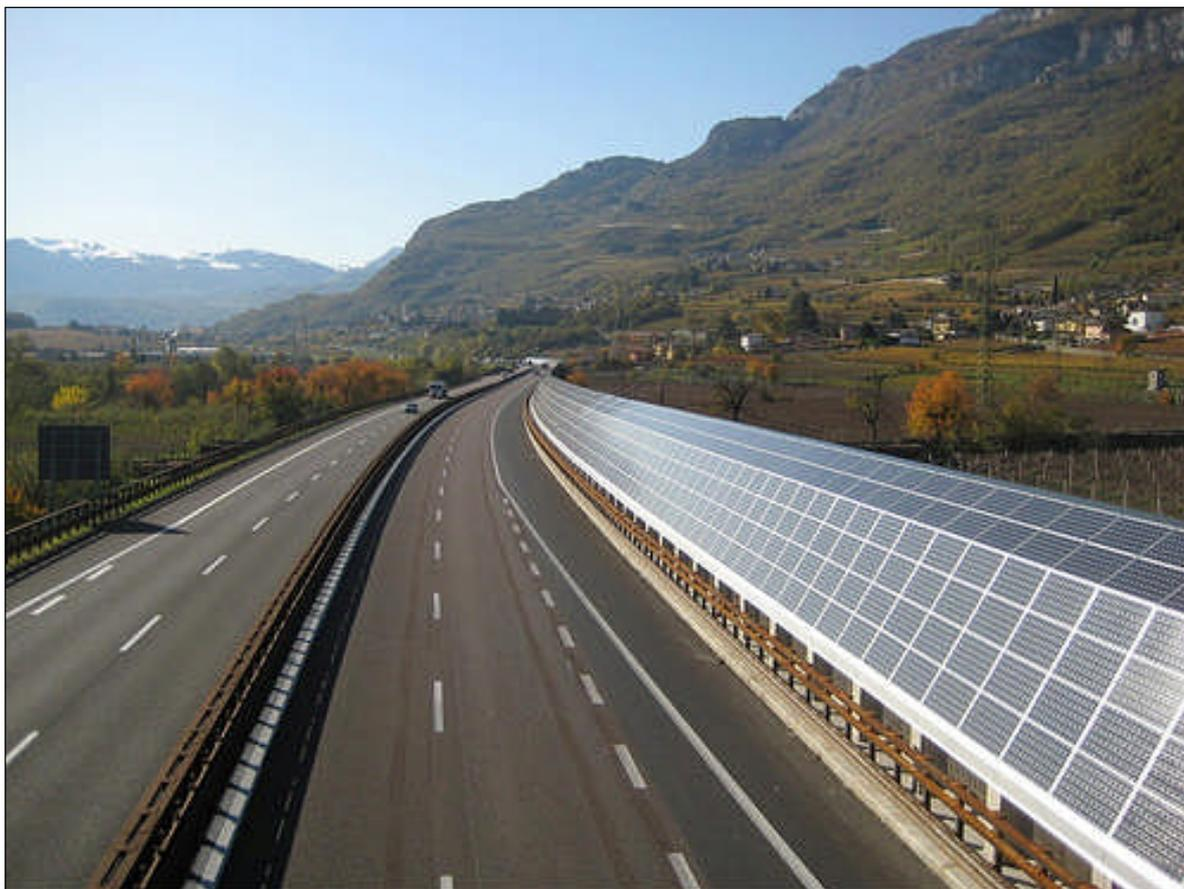
Figure 8 : Un exemple de solution multifonctionnelle intégrée où des cellules photovoltaïques ont été incorporées dans des écrans antibruit.
