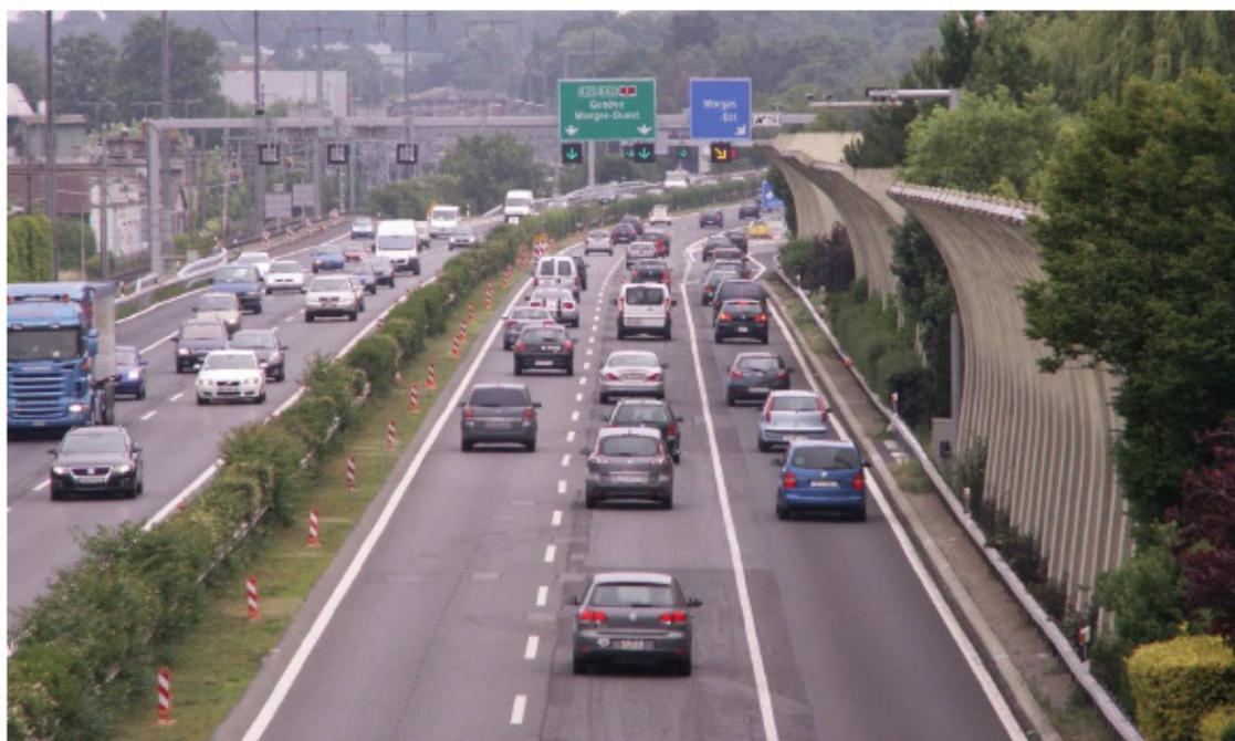
Figure 18 : Circulation sur la bande d'arrêt d'urgence entre Morges et Ecublens (projet pilote en Suisse)
