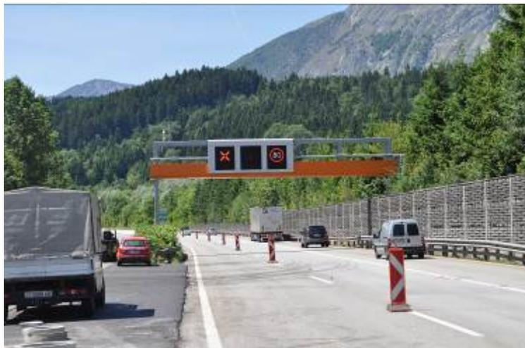
Figure 15 : La gestion des voies et de la vitesse est une partie des systèmes autrichiens de contrôle des files (Line Control Systems).
