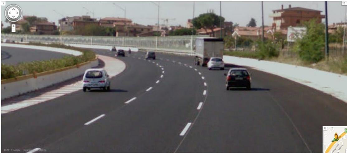
Figure 28 : Bandes sonores en saillie utilisées sur l'accotement de gauche sur le périphérique de Rome.
