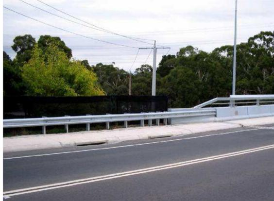
Figure 75 : Raccordement entre une barrière semi-rigide et une barrière rigide [A.40][A.40]
