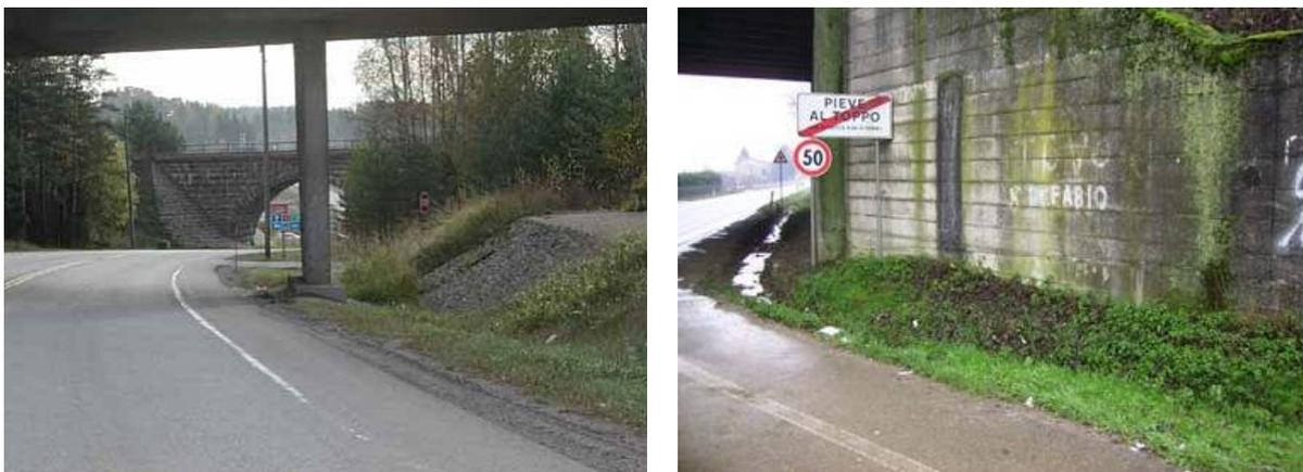
Figure 52 : Exemples de culée de pont (gauche) et de passage supérieur (droite) dangereux (Source : [A.2][A.2])
