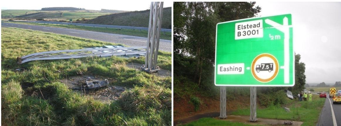
Figure 39 : Support fragilisé après avoir été percuté par un véhicule léger [58][58]
