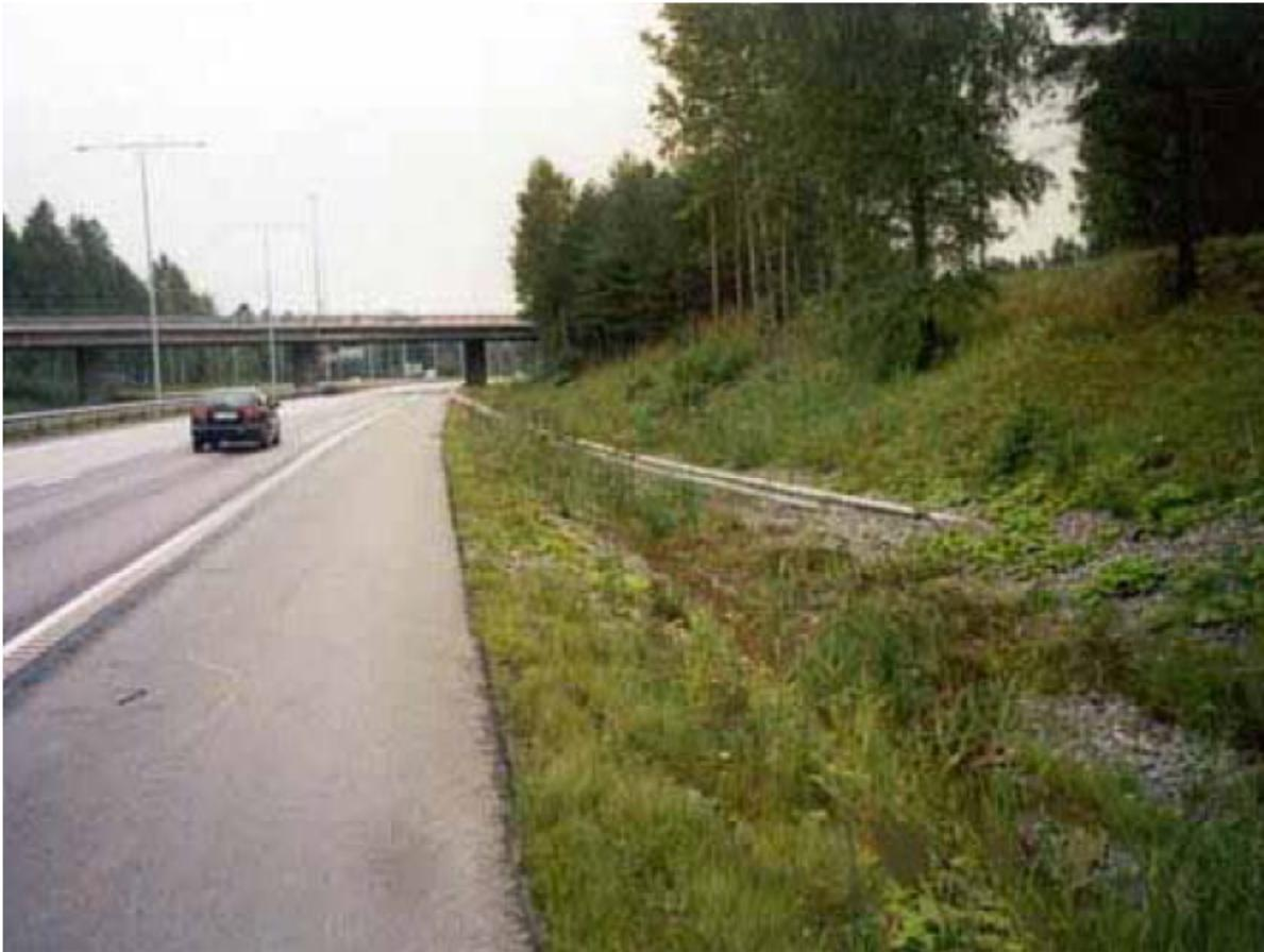
Figure 12 : Extrémité enfouie dans un revers de pente [1]<sup>11</sup>
