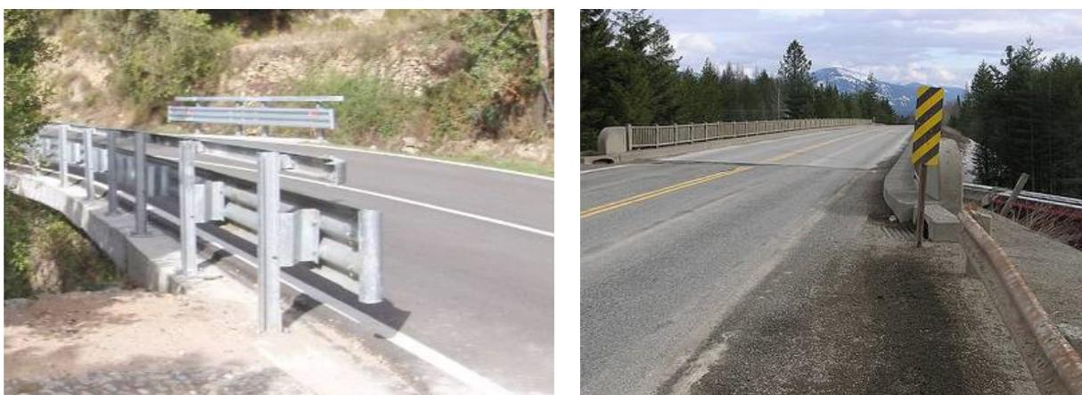
Figure 53 : Exemples d'extrémités de glissières de sécurité dangereuses
