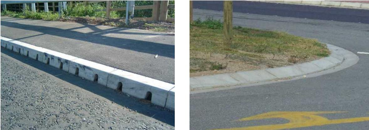
Figure 73 : Bordure verticale (gauche) et bordure inclinée (droite)
