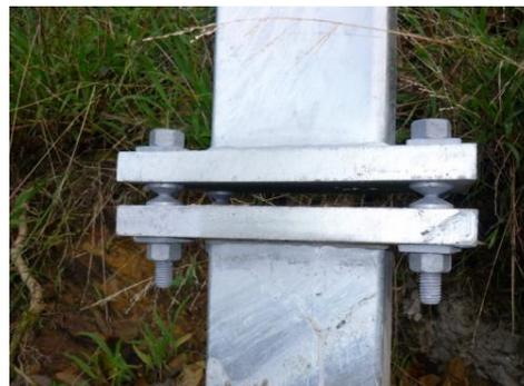
Figure 37: Poteau frangible/éclissé (gauche) et à embase glissante (droite) [57]
