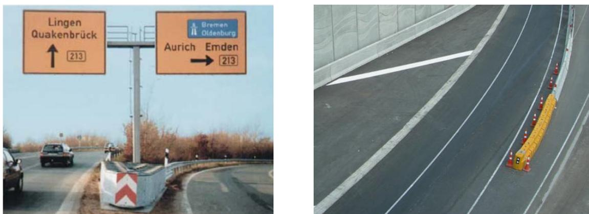
Figure 82 : Exemples d'atténuateurs d'impact (Sources : [A.2][A.2] et [A.51][A.51])
