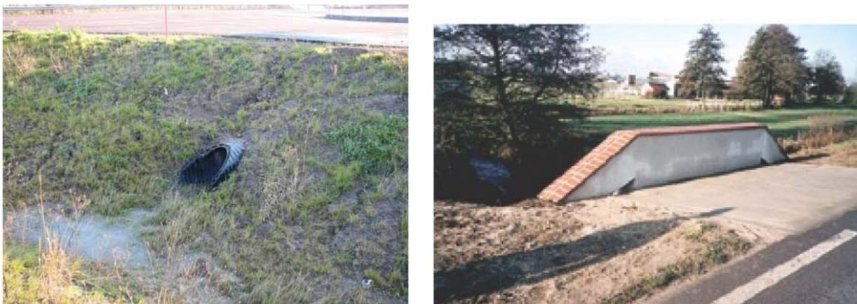
Figure 72 : Extrémité de ponceau biseauté (gauche) et parapet chanfreiné (droite) (Sources : [A.2], [A.27][A.2][A.27])
