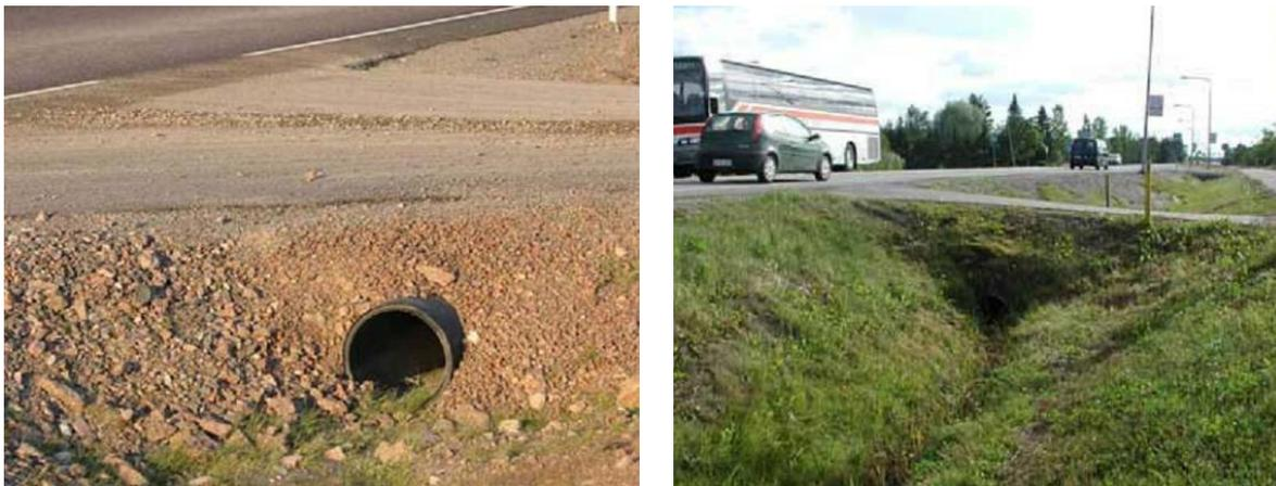
Figure 55 : Exemples d'ouvrages de drainage dangereux (Source : [A.2][A.2])
