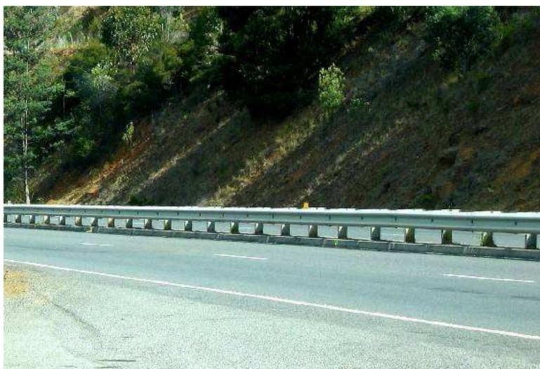
Figure 78 : Glissière classique à double ondulation pour terre-plein central [A.40][A.40]
