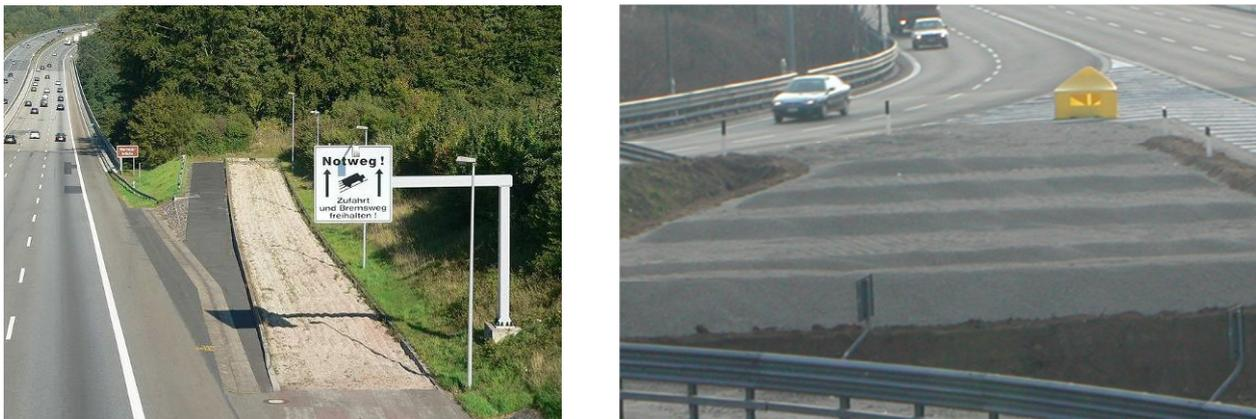
Figure 68 : Exemples de voies de détresse [A.50][A.50] et lits d'arrêt
