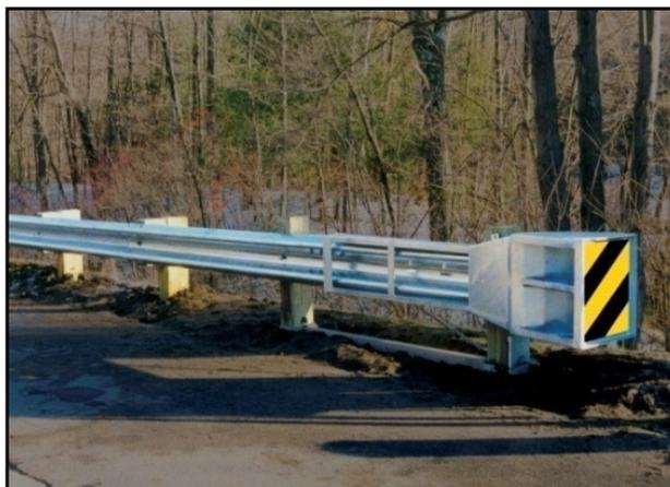
Figure 11 : Extrémité générique Midwest à absorption d'énergie
