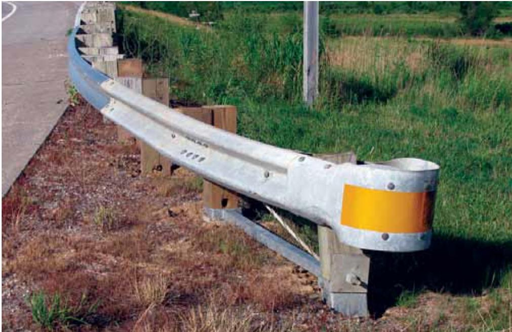
Figure 7: Extrémité générique de type *Modified Eccentric Loader Terminal (MELT)* pour le niveau TL-2 [10]
