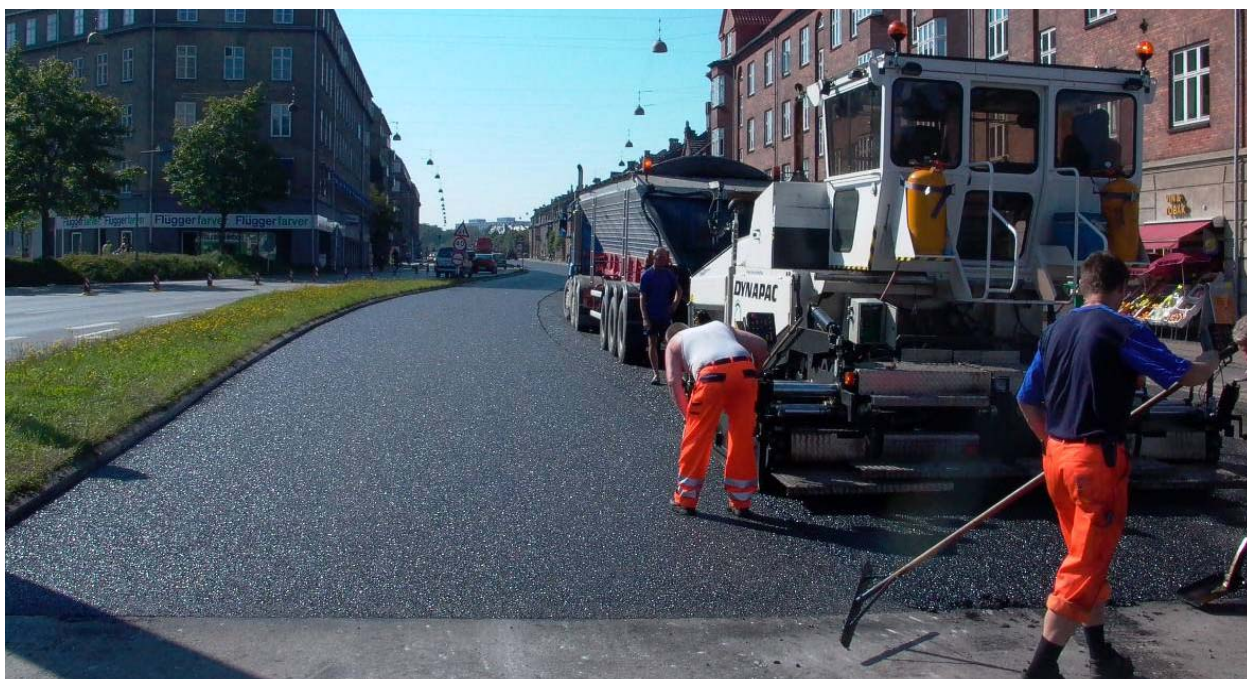
Figure 7.1 : Le type de revêtement utilisé influence le niveau de bruit engendré par les pneus/le revêtement sur une route donnée. Ici, pose double couche d'un revêtement poreux réducteur du bruit sur une route principale dans Copenhague (Danemark), dans le cadre du processus de entretien permanent.
