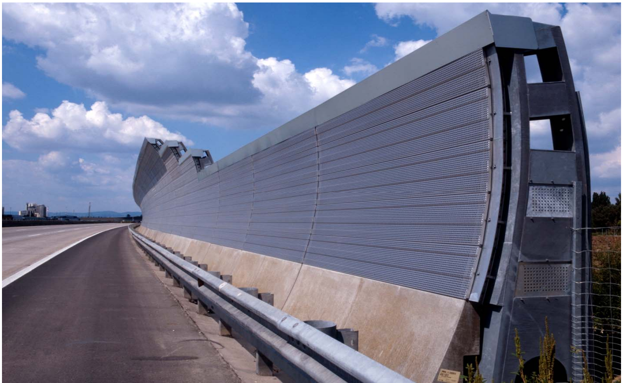
Figure 8.27: Exemple d'écran anti-bruit à hauteurs échelonnées, en virage ; les dimensions de l'écran peuvent varier en fonction de l'emplacement
