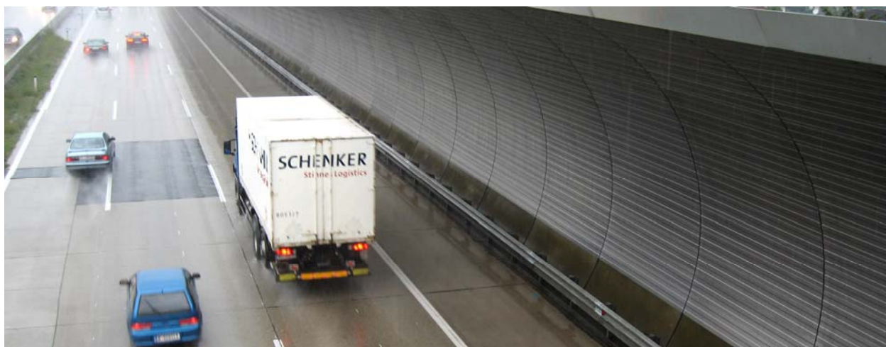
Figure 4.4 : L'autoroute reliant Vienne et l'aéroport international s'est vue ajouter des voies supplémentaires. Une longue section de l'autoroute longe un quartier résidentiel. Afin de réduire la pollution sonore, un écran anti-bruit incurvé a été construit, haut de 5,5 mètres et surplombant en partie la chaussée.
