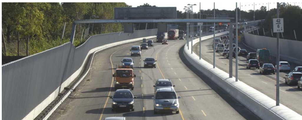
Figure 4.1 : Le périphérique ceinturant Copenhague (Danemark) passe de quatre à six voies dans un quartier résidentiel dense. Afin de réduire le bruit, des revêtements à couche mince réducteurs du bruit et des murs anti-bruit hauts de 4 mètres sont inclus dans ce grand projet de réaménagement routier.
