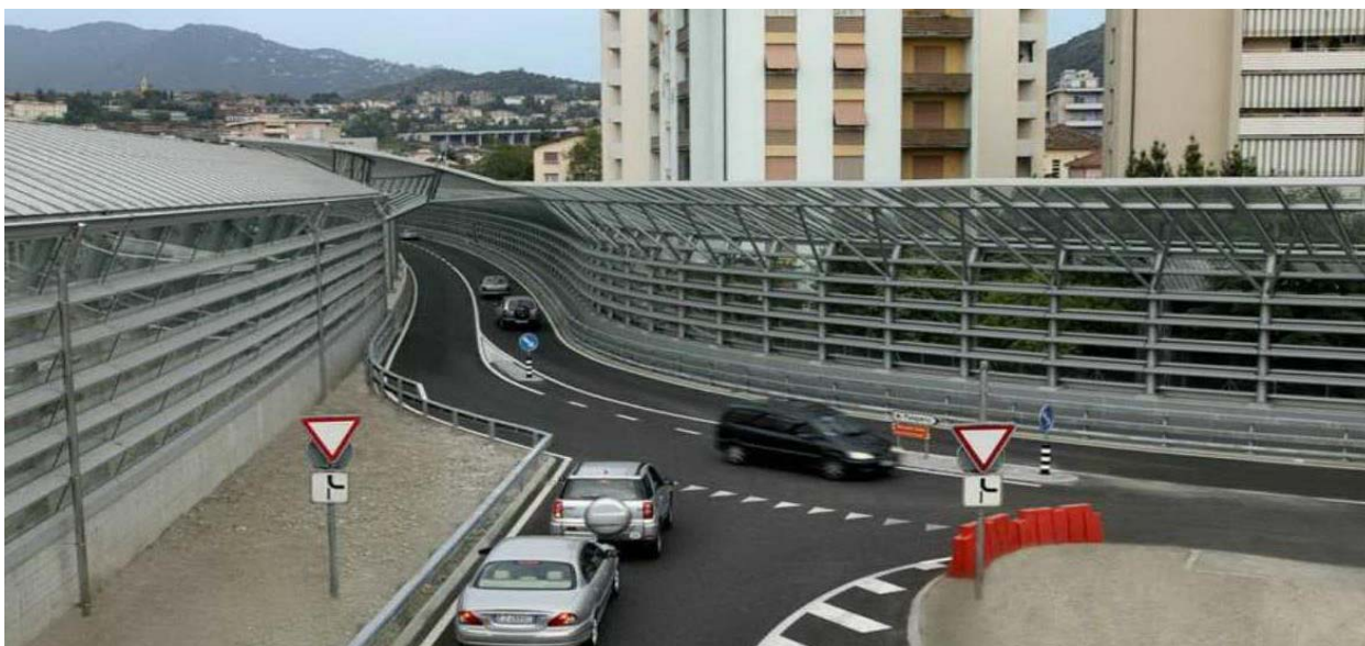
Figure 8.3 : Italie : ensemble sophistiqué d'écrans anti-bruit en milieu urbain
