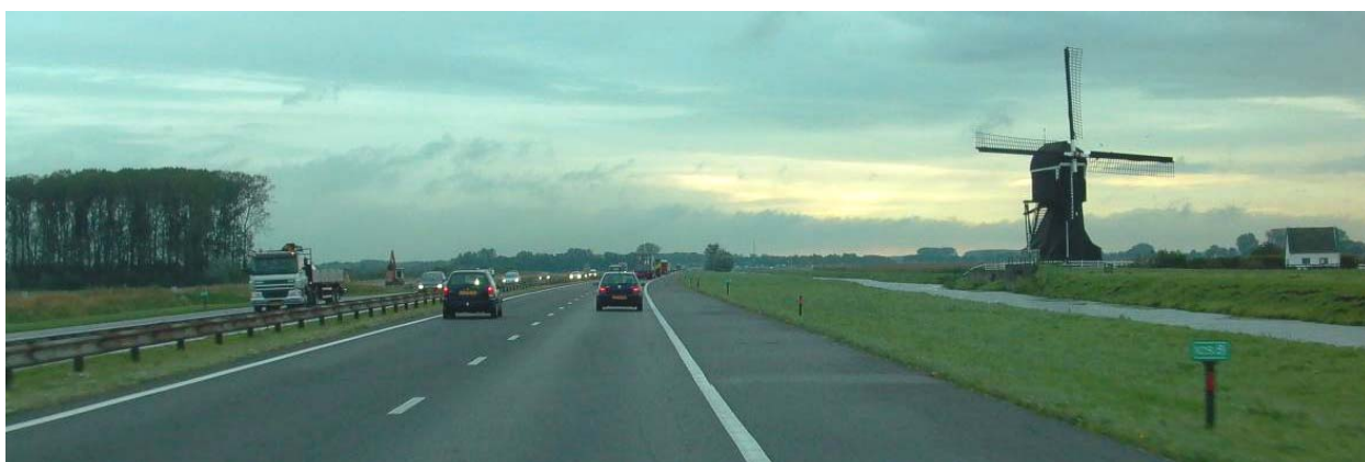
Figure 7.2 : Aux Pays-Bas, une directive politique nationale stipule d'utiliser de l'asphalte poreux sur les grandes routes. En 2008, environ 80 % du réseau était revêtu d'asphalte poreux
