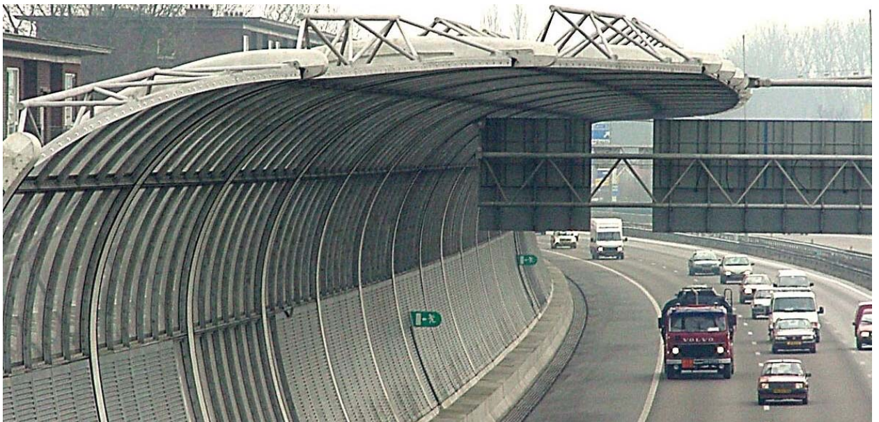
Figure 8.24 : Autre exemple d'écran anti-bruit incurvé aux Pays-Bas ; dans ce cas, il recouvre partiellement la route. Les écrans peuvent être conçus pour offrir une atténuation supplémentaire dans les zones où se trouvent des récepteurs sensibles.
