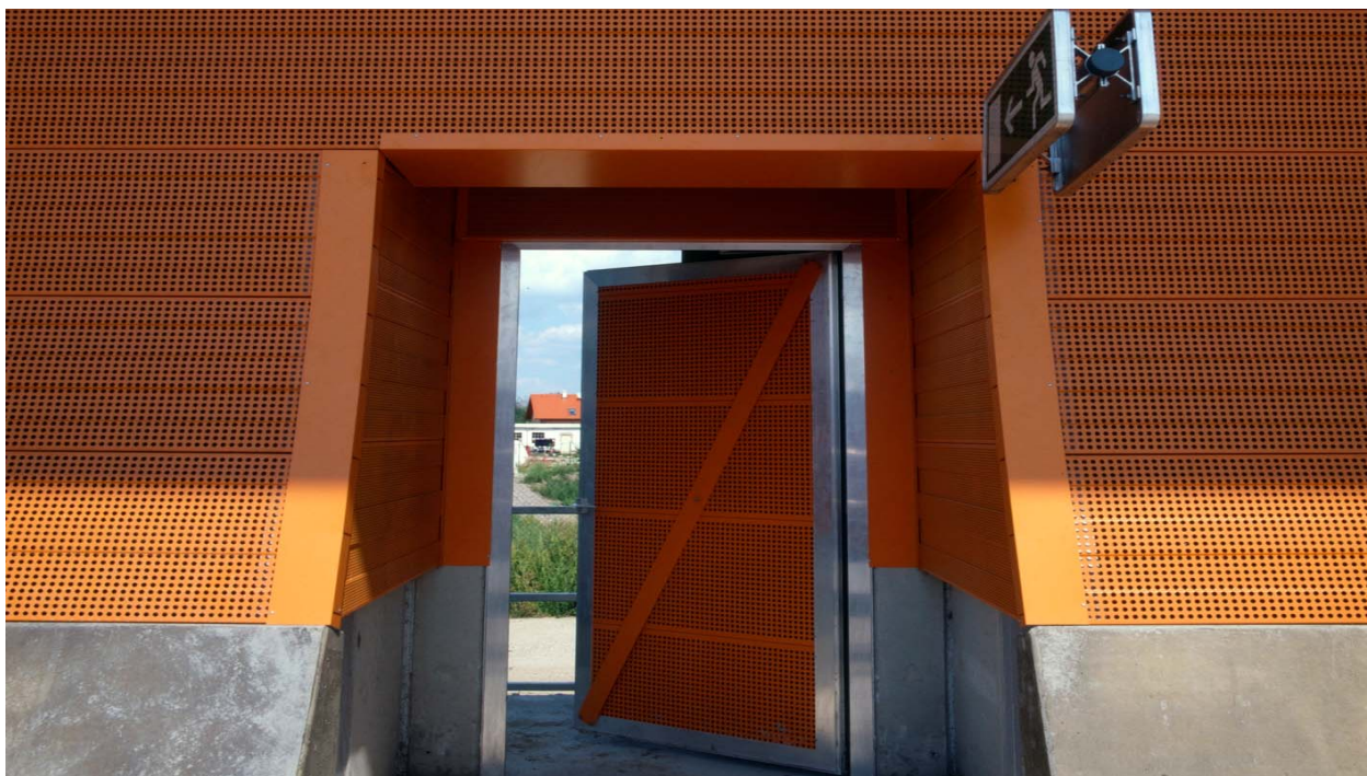
Figure 8.17 : Exemple d'une porte d'accès bien construite ; cette porte est parfaitement jointive en position fermée
