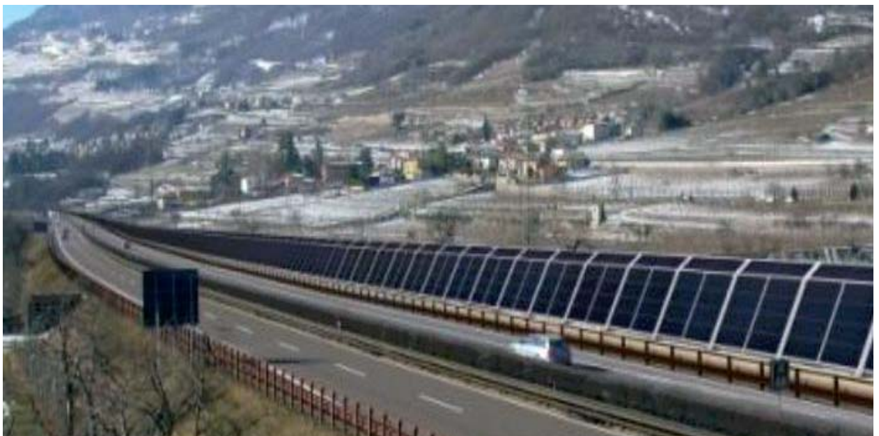
Figure 8.6 : Dans cet exemple, l'écran anti-bruit fait appel à des panneaux solaires, lesquels jouent un double rôle : ils atténuent le bruit et génèrent l'électricité destinée à la route ou au réseau
