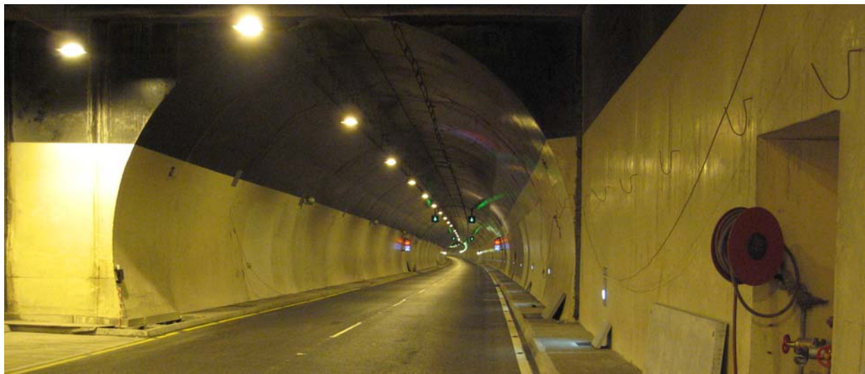
Figure 4.2 : Le projet du tunnel sous le port de Dublin vient de s'achever. Son objectif : canaliser le trafic poids lourd vers le port de Dublin et décongestionner ainsi le réseau de routes principales innervant le centre-ville. On s'attend également à ce que la diminution du nombre de véhicules industriels lourds réduise le bruit le long du réseau routier existant.
