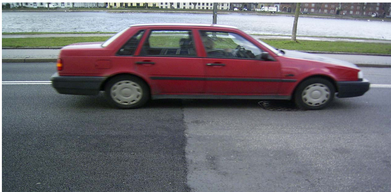
Figure 8.7: Exemple d'une nouvelle surface peu bruyante à Copenhague : le revêtement de gauche engendre un bruit inférieur de 6 dB(A) à celui de l'asphalte dense à droite [20]
