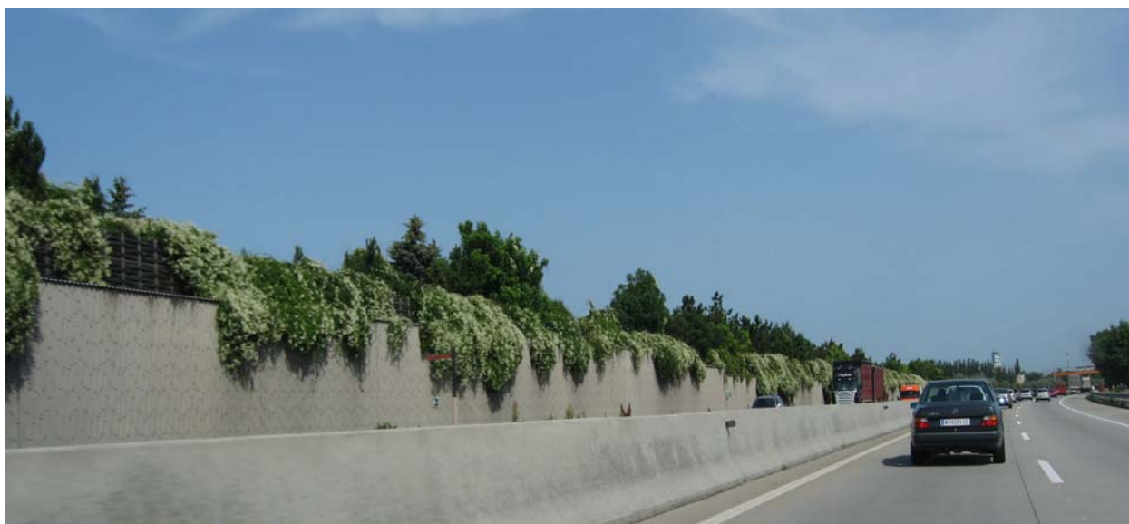
Figure 8.11 : Exemple d'écran anti-bruit en béton, avec arête supérieure végétalisée. La végétation au sommet de l'écran peut potentiellement impacter sur ses propriétés acoustiques.
