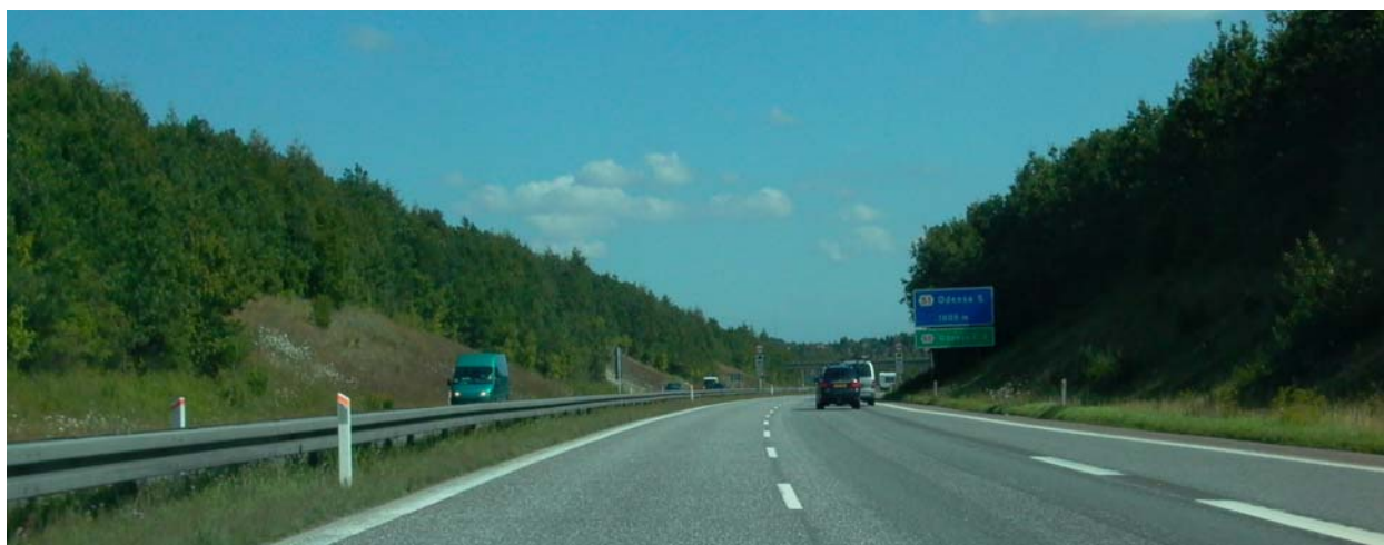
Figure 8.1 : Danemark : une berme de terre végétalisée sert d'écran anti-bruit
