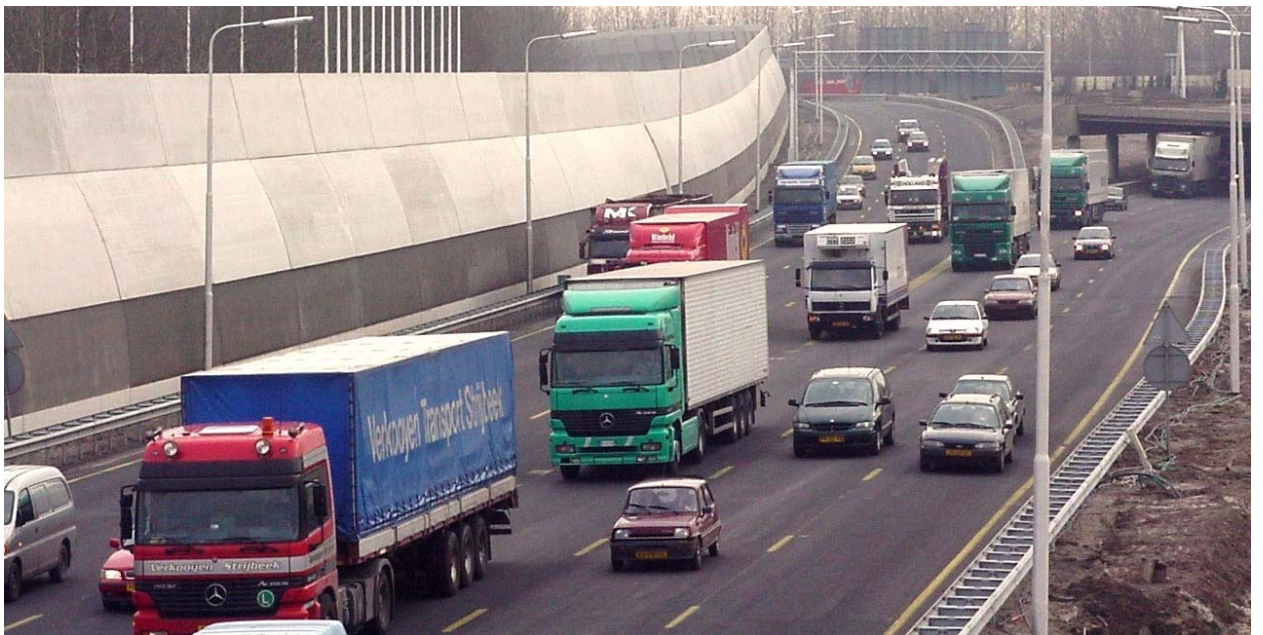
Figure 8.28 : Dans ce cas, l'écran anti-bruit construit mesure environ 8 mètres de haut et atténue ainsi plus fortement le bruit
