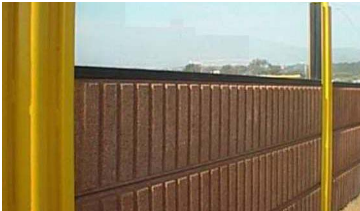
Figure 8.13 : Écran anti-bruit composé de Woodcrete® et d'un bandeau transparent au dessus de l'écran. A noter les robustes poteaux-supports. Le Woodcrete® est un mélange de béton et de bois auquel on peut conférer de la couleur pour l'harmoniser avec l'environnement.
