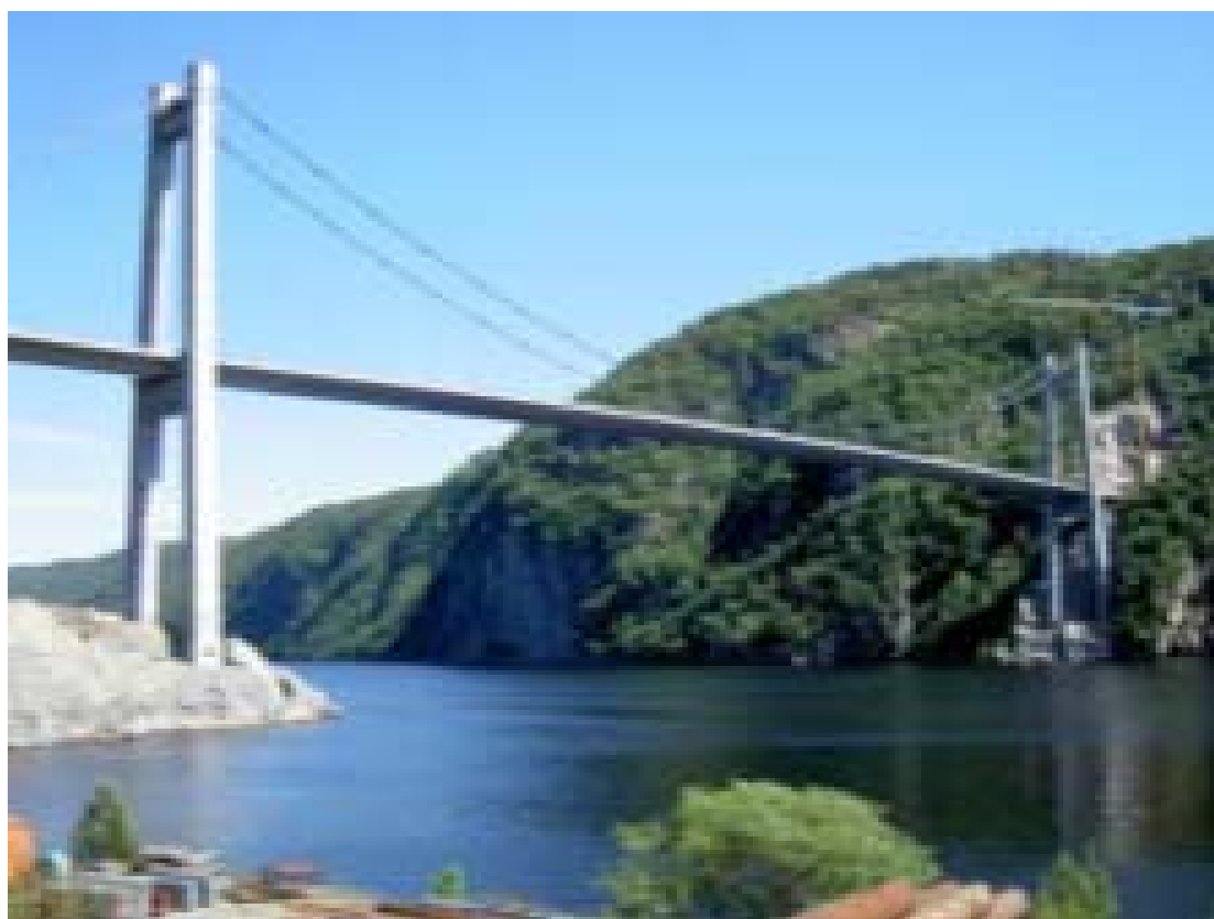
Pont Fedafjorden, route E39, tronçon Lyngdal-Flekkefjord, Norvège
