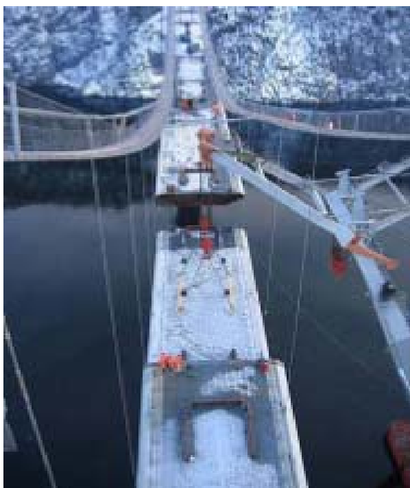
Construction du pont de Fedafjorden, route E39, tronçon Lyngdal-Flekkefjord, Norvège
