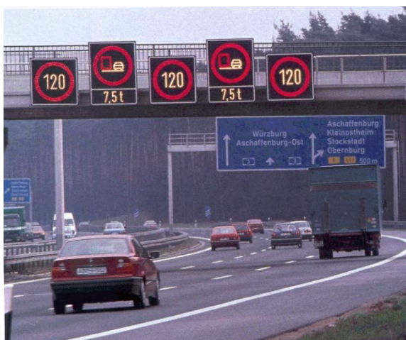
Fig. 14 : système allemand de gestion des voies
