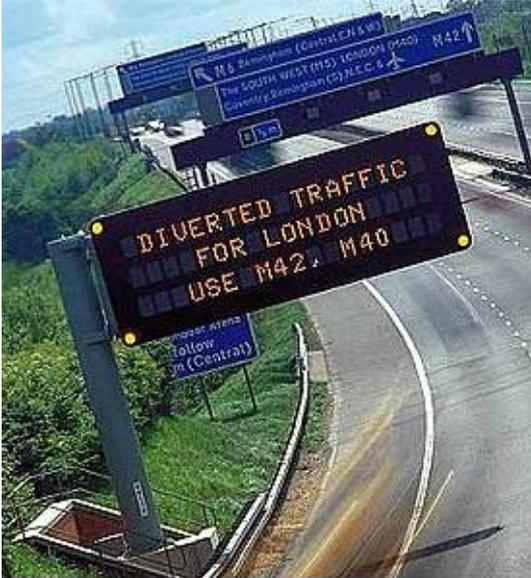
**Fig. D7 : Panneau à messages variables de type MS3**
