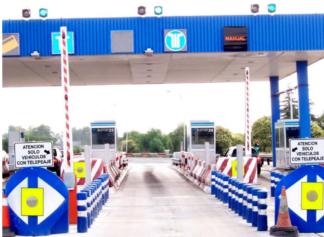
Poste de péage en Espagne (Playas de peaje de la Autopista de San Juan. Aumar)
